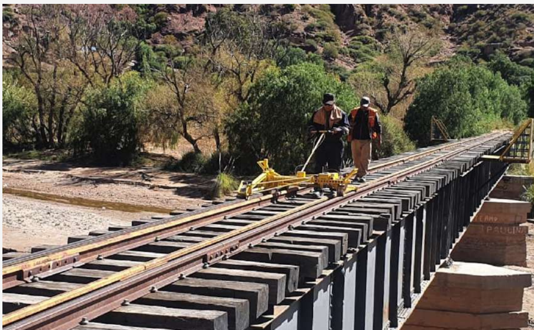
Inspección vía – Puente Entre Ríos Tupiza
