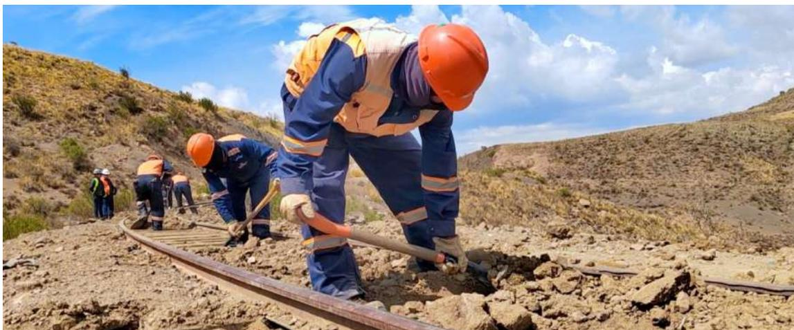
Obreros realizan mantenimiento de vía en el tramo Potosí - Agua Castilla.
