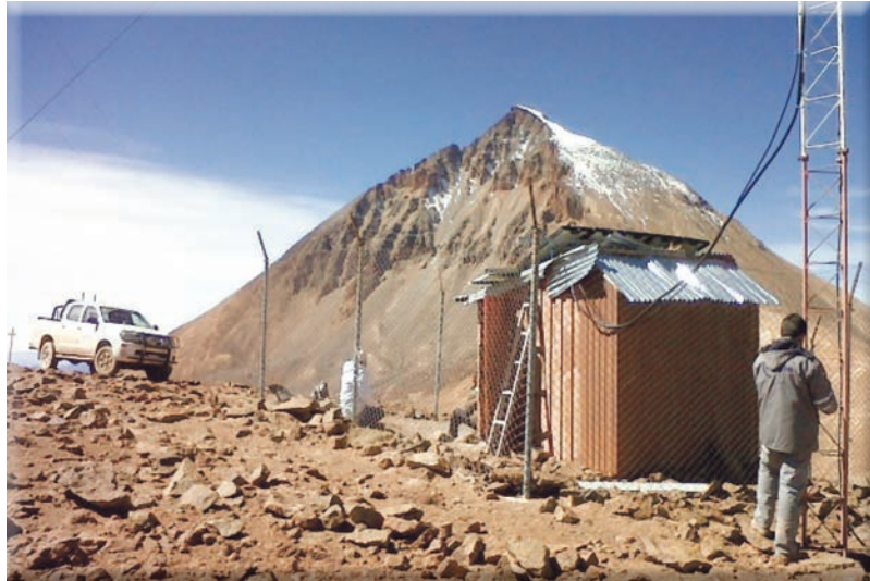
Trabajo de nuevo aterramiento en repetidora Nazarenito
